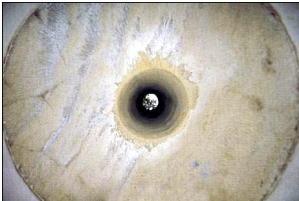
La volta della Malta, e il condotto perfettamente circolare, che, dopo un percorso di 20 metri, raggiunge la superficie (da: Menghini A., Menghini F. - Isola bisentina... p.88).
